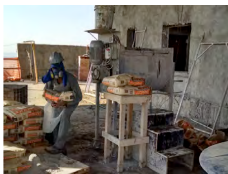
Figura 4 – Processo de mistura na obra B
