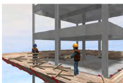
Figura 3 – Desmontagem das Bandejas Urbe
