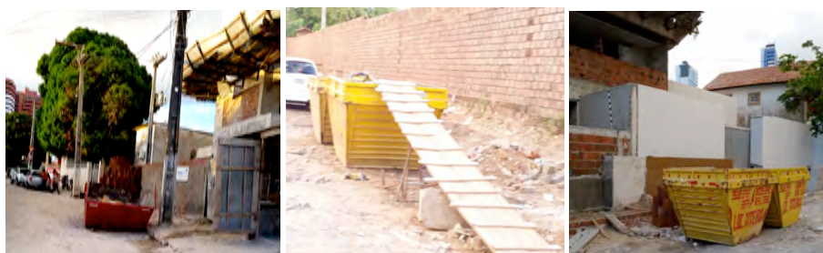
Figura 2 - Localização de caçamba estacionária nos canteiros de obras
