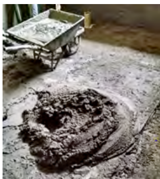
Figura 3 – Obra A - Chegada da argamassa no pavimento
