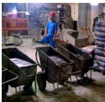
Figura 2 – Obra A – Argamassa após a mistura na betoneira
