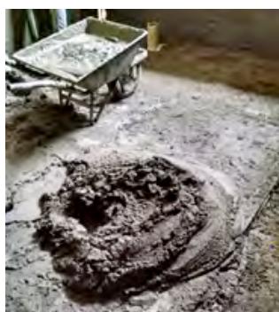
Figura 3 – Obra A - Chegada da argamassa no pavimento
