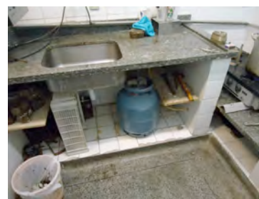
Figura 4 – Botijão de gás armazenado em local confinado no laboratório
