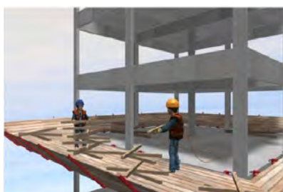
Figura 3 – Desmontagem das Bandejas Urbe
