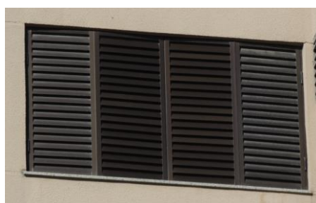
Figura 10- Detalhe da veneziana como ECS - edificação 1.
