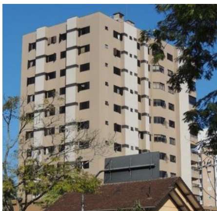
Figura 8- Fachadas nordeste (NE) e noroeste (NO) – edificação 1.
