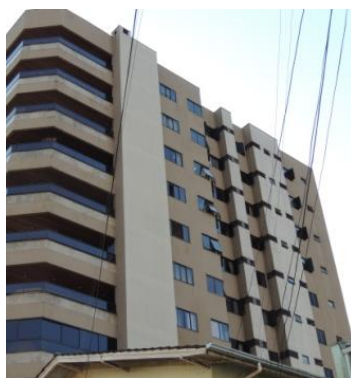
Figura 7- Fachada lateral sudeste (SE) - edificação 1.
