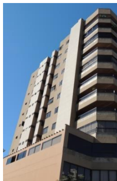
Figura 6- Fachadas noroeste (NO) – edificação 1.
