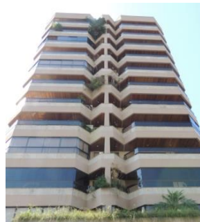
Figura 5- Fachada frontal sudoeste (SO) - edificação 1.
