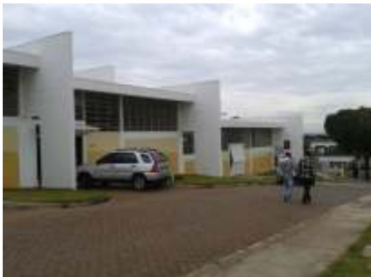
Figura 1 – Fachada do laboratório
