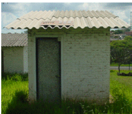
(a) Protótipo no canteiro experimental.
