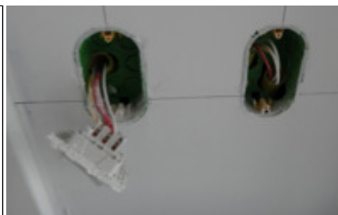
Figura 7 – Posicionamento de caixas elétricas
