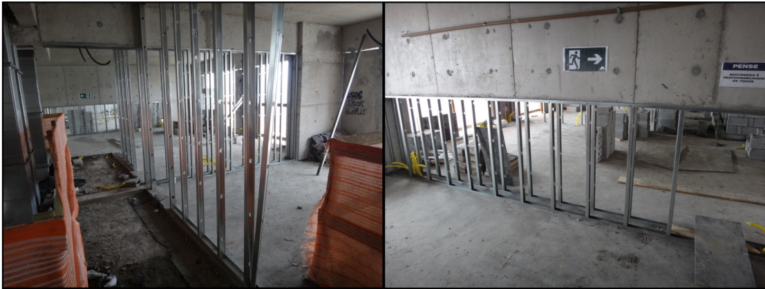
Figura 1 – Montagem dos perfis
