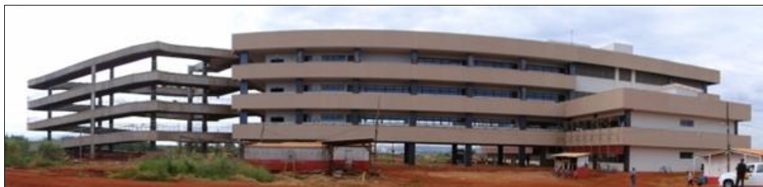
Figura 1 – Bloco 1AMC, em execução.
