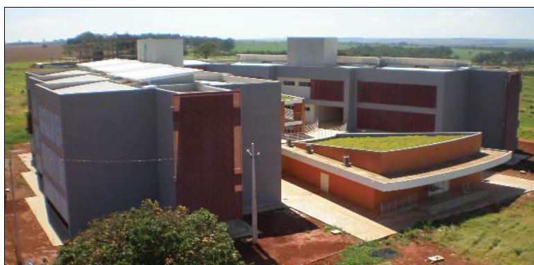
Figura 2 – Bloco 1BCG, em execução.
