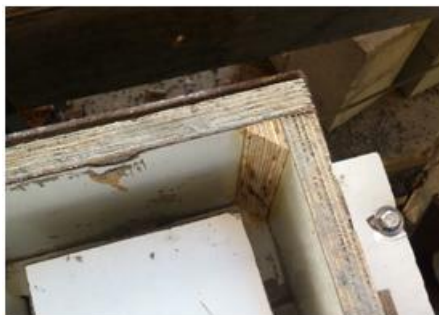
Figura 6– Detalhe da peça adicional com corte a 45° instalado na peça n° 2.
