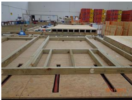
Figura 2 – Pré-fabricação dos painéis de parede e piso do conjunto Haragano
