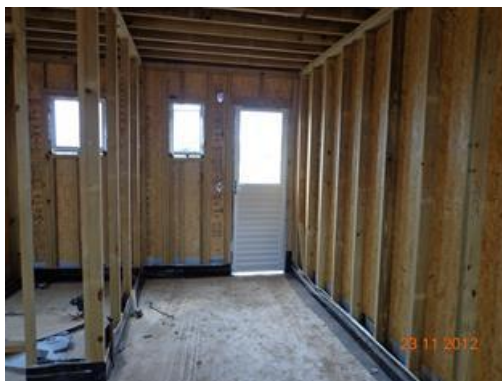
Figura 3 – Montagem dos painéis de parede e piso no canteiro de obras
