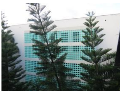
Figura 2 – Entorno (Obstruções externas) visto da janela da sala B.
