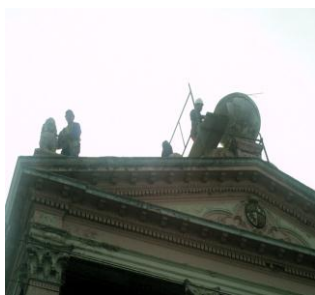
Figura 03a- Foto do telhado
