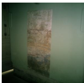
Figura 03b- Foto do forro do salão principal
