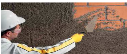
Aplicação com colher de pedreiro Fonte: www.weber.com.br
