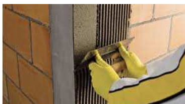
Aplicação com desempenadeira dentada Fonte: www.weber.com.br
