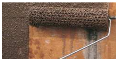
Aplicação com rolo para textura acrílica Fonte: www.weber.com.br
