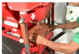
Figura 3 - Bloco de RCD na prensagem
