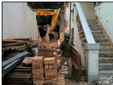
Figura 1 - Caso raro de demolição de residência com retirada cuidadosa dos materiais para reuso em Juiz de Fora.
