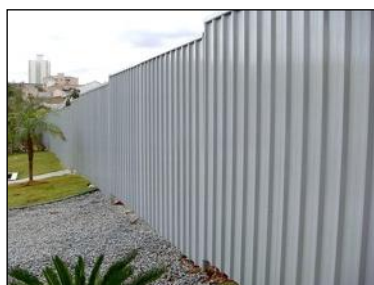
Figura 5 - Tapume de obra de telha de alumínio para reúso como cobertura e contêineres metálicos para reúso como paredes ou cômodos inteiros.
