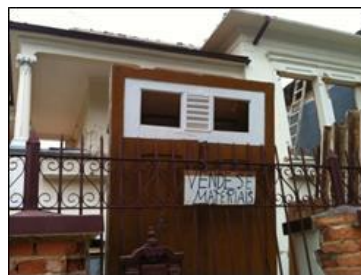
Figura 1 - Caso raro de demolição de residência com retirada cuidadosa dos materiais para reuso em Juiz de Fora.
