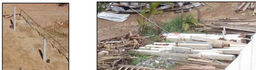
Figura 3 - Bombona plástica. Reúso como fôrma para bloco de fundação.
