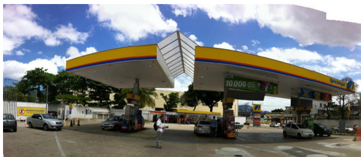
Figura 5 – Foto do céu - medição: 27/09/2013 às 12:30h – sensores desligados com lâmpadas acesas
