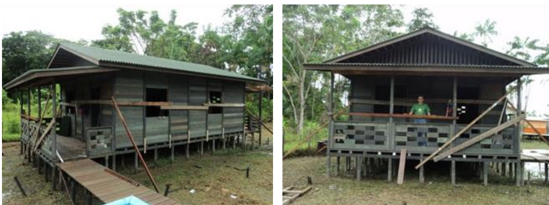
Figura 7 – Exemplo de sistema construtivo em madeira plástica
