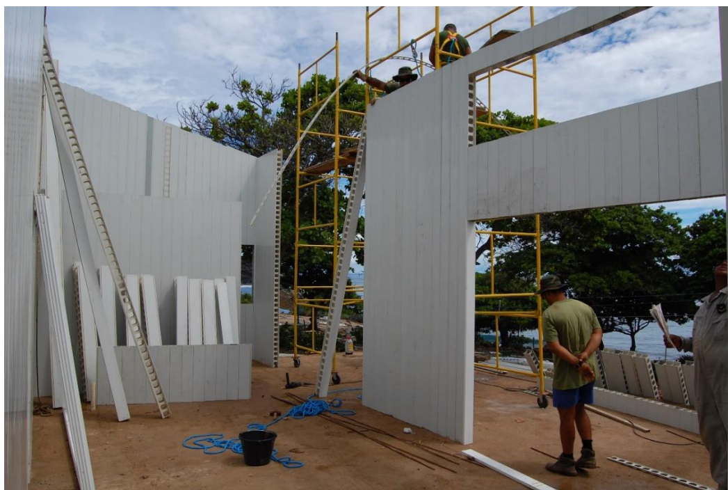
Figura 4 – Sistema construtivo concreto-PVC (Ilha da Trindade)
