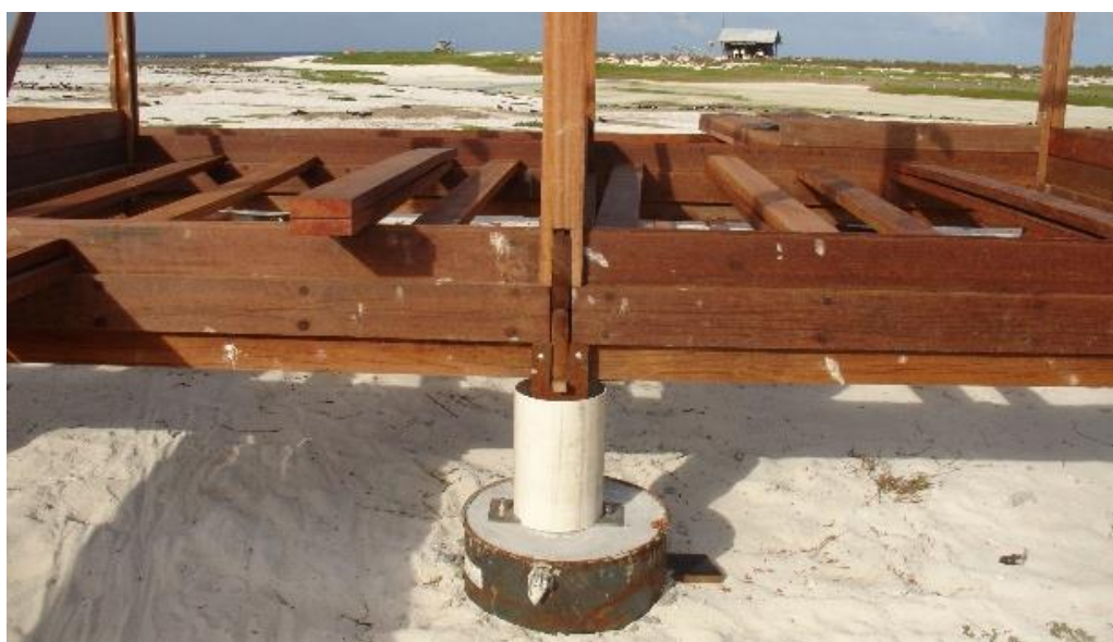
Figura 6 – Sistema construtivo pré-fabricado em madeira (Atol das Rocas)
