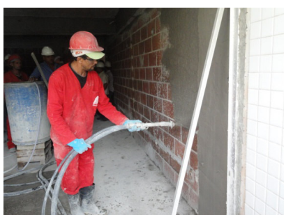
Figura 9 - Projeção da argamassa em direção ao piso
