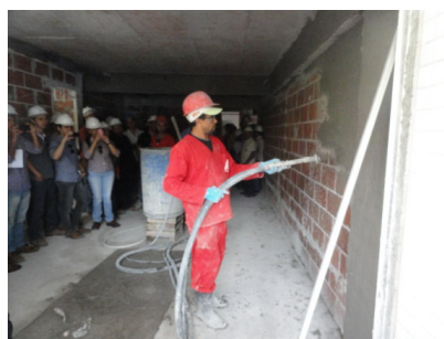
Figura 8 - Projeção da argamassa no meio da alvenaria
