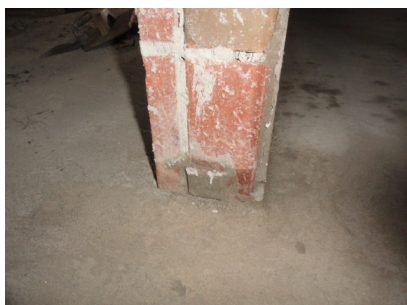
alvenaria na área seca
