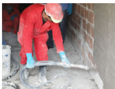
Figura 10 - Projeção da argamassa na parte inferior da alvenaria
