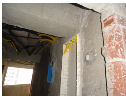
Figura 4 - Chapisco e taliscas na alvenaria da cozinha
