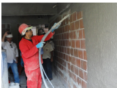
Figura 7 – Projeção da argamassa na parte superior da alvenaria
