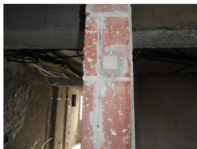
alvenaria na área seca
