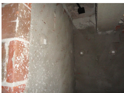
Figura 3 – Chapisco e taliscas na alvenaria do banheiro
