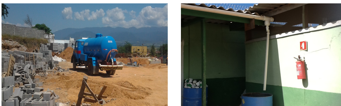
(a) Caminhão pipa para irrigar canteiro
