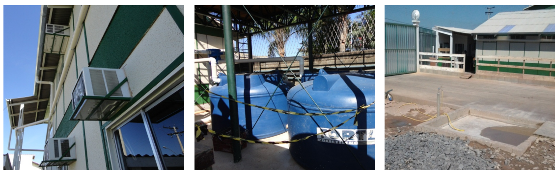
(a) Captação de água de chuva por telhado com calhas de PVC
