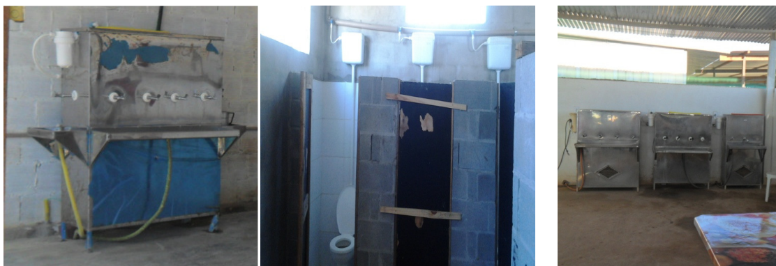
(a) Abastecimento de água para consumo -Obra A
