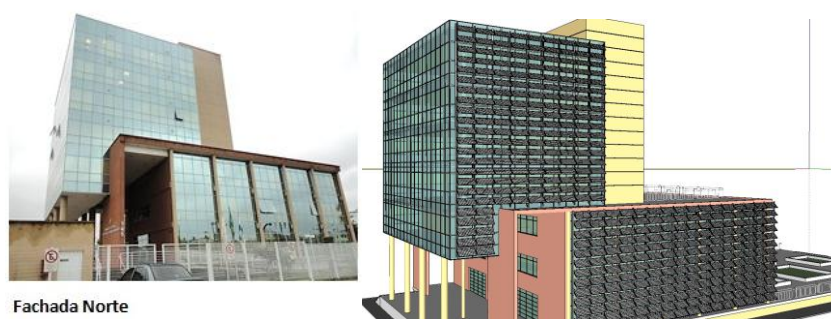
Figura 8– Prédio da Justiça Federal (Juiz de Fora, MG): Foto Retirada no Local (à esquerda) e Modelagem Virtual com colocação de Brise-Soleil (à direita)
