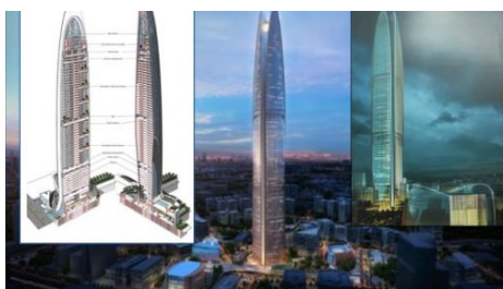
Figura 6 – Projeto do edifício da Companhia Pertamina, em Jacarta, Indonésia
