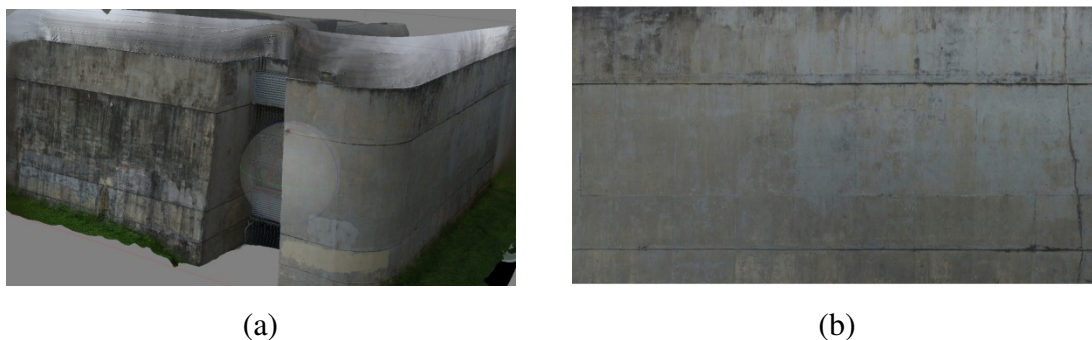
Figura 4 – Modelo tridimensional da Biblioteca Central da UnB gerado no PhotoScan (a) e ortoimagem de uma das fachadas da Biblioteca Central da UnB (b)
