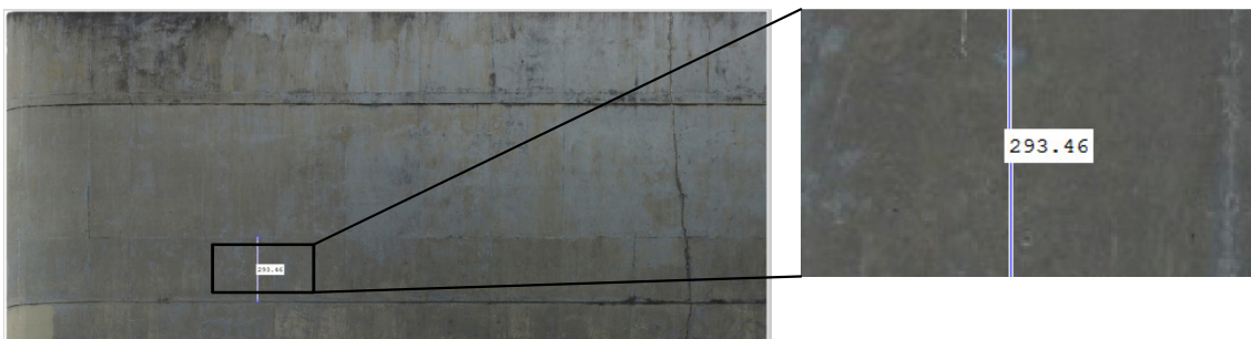
Figura 5 – Verificação da quantidade de pixels em distância conhecida na fachada da Biblioteca Central da UnB
