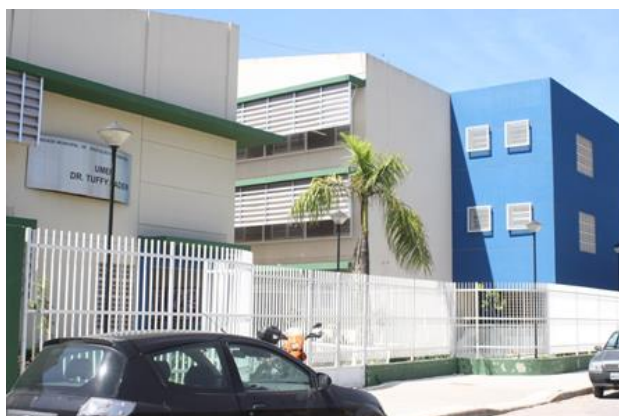
Figura 05 – Vista externa do edifício com os brises horizontais na fachada
