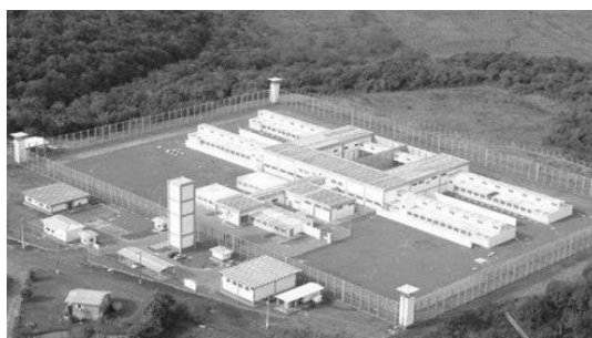
Figura 7 - Tipologia poste telegráfico ou espinha-de-peixe
