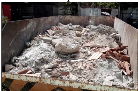
Figura 6 - Caçamba com segregação adequada
