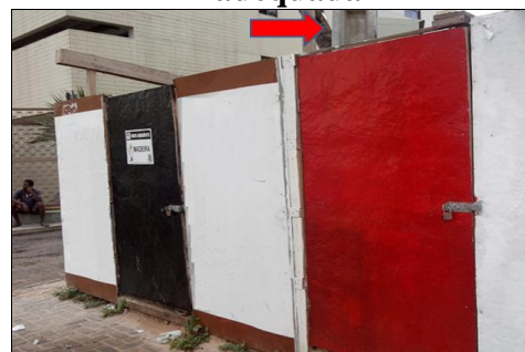
Figura 9 - Baias com localização inadequada
