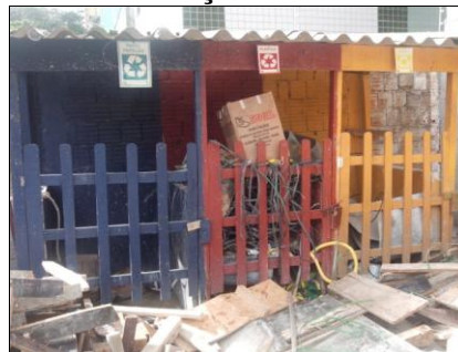
Figura 5 - Utilização de baias nas obras
