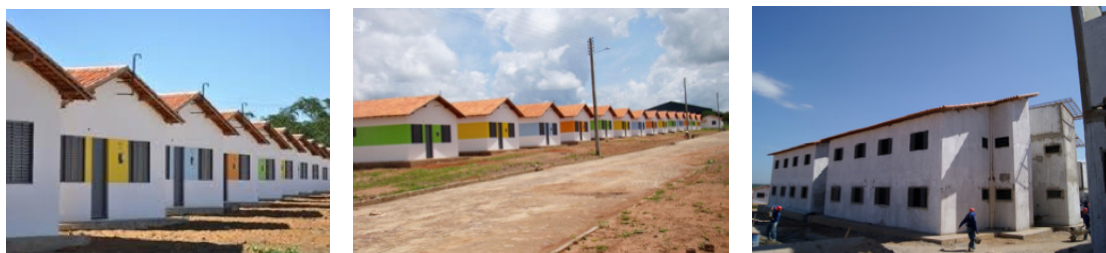
Figura 4- Habitação no sistema misto pré-moldado de concreto armado e blocos cerâmicos. Casas e apartamentos em Teresina, PI
