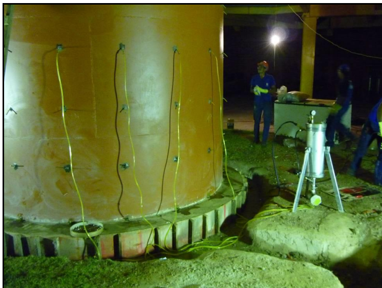
Figura 11 - Sistema de injeção da resina.
