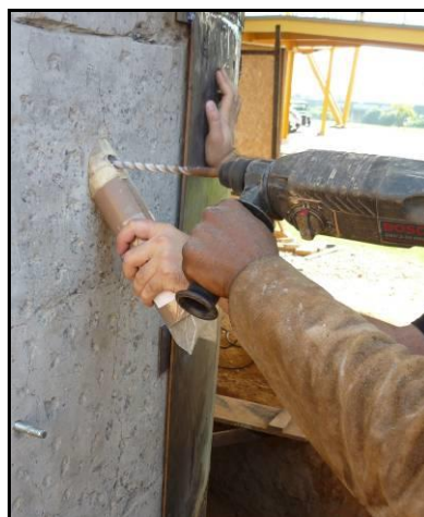
Figura 08 - Retirada de amostra para determinação do teor de sulfatos no pilar.
