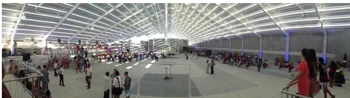
Figura 3. Fotografia Panorâmica da obra concluída
