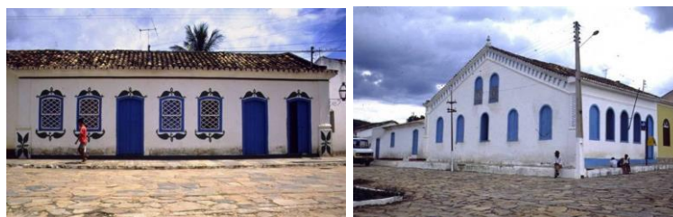
Figura 2 – Construções coloniais de terra crua - MG
