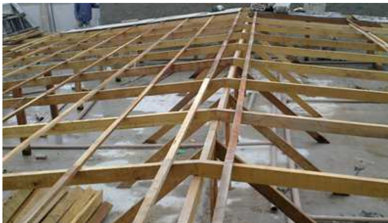
Figura 1 - Execução do projeto preliminar em obra piloto
