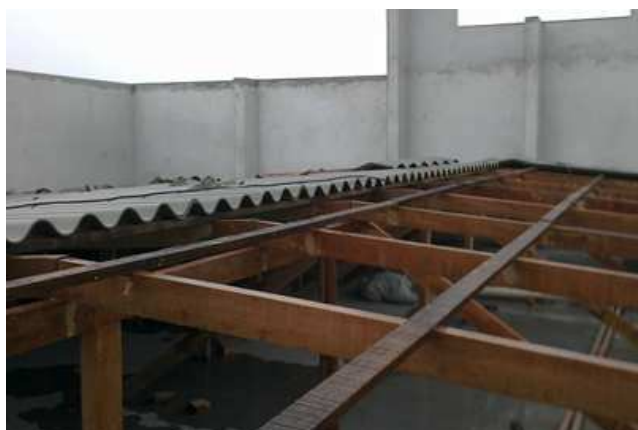
Figura 6 – Execução da cobertura na obra seguinte ao protótipo
