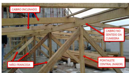
Figura 8 - Pontalete central travado por mãos francesas e por um caibro no sentido da cumeeira
