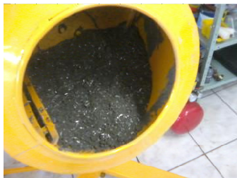
FIGURA 02: Mistura da argamassa com adição de fibras de alumínio.
