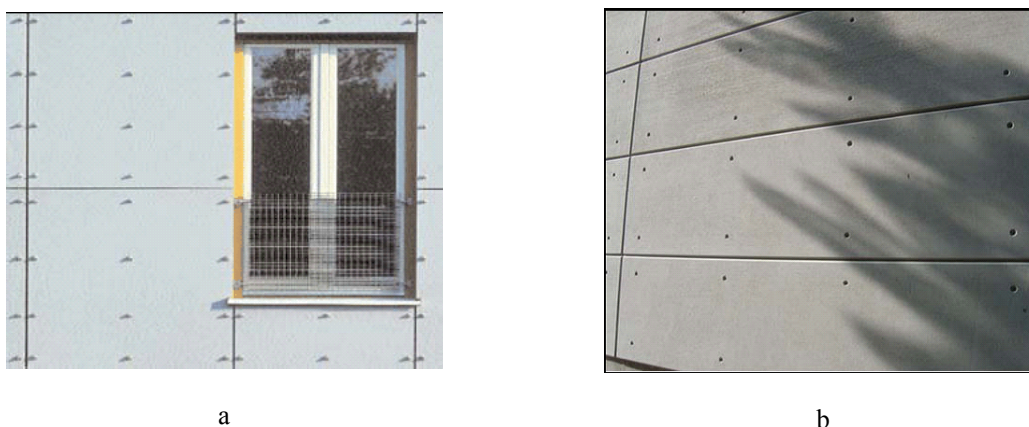
Figura 1: Exemplos de fixação aparente a: Sistema Naxo (ETERNIT, 2007); b: Fachada TEK- (PLYCEM, 2005).
