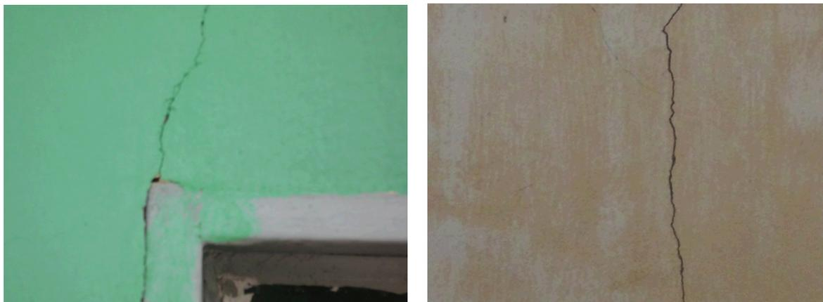
Figura 1-b) Fissura em torno de janela e b) fissura vertical em parede
