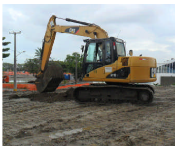
Figura 5. Coleta da amostra de solo da estaca.
