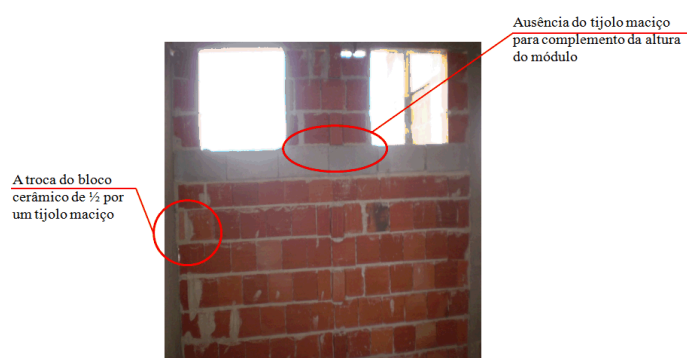
Figura 6 – Elevação de alvenaria destacando a não utilização de tijolos maciços conforme especificado em projeto
