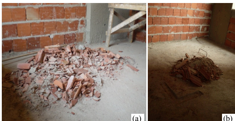
Figura 8 - Quantidade de lixo residual de um mesmo conjunto de elevações: (a) antes da implantação do projeto; (b) após a implantação do projeto
