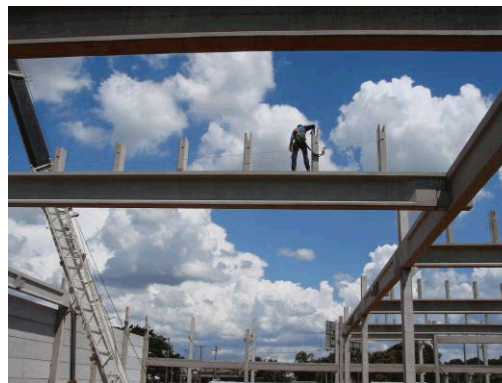
Figura 6 – Funcionário amarrado corretamente a cabo guia
