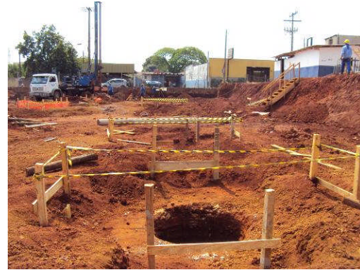
Figura 2 – Proteção com fita zebraada dos buracos dos tubulões escavados
