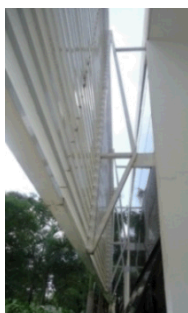
Casa do Professor - Brise metálico de haletas paralelas
