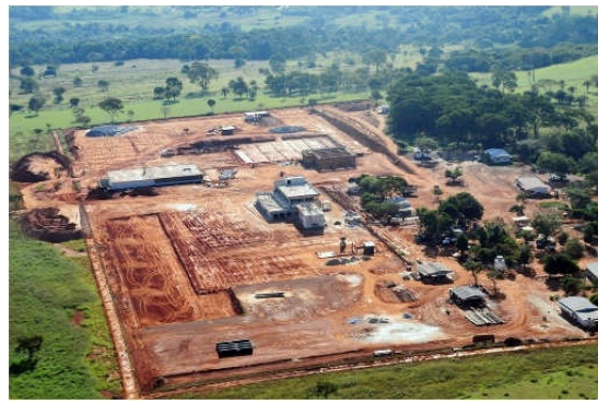
Figura 2 – Obra de infraestrutura de saneamento do estudo de caso B
