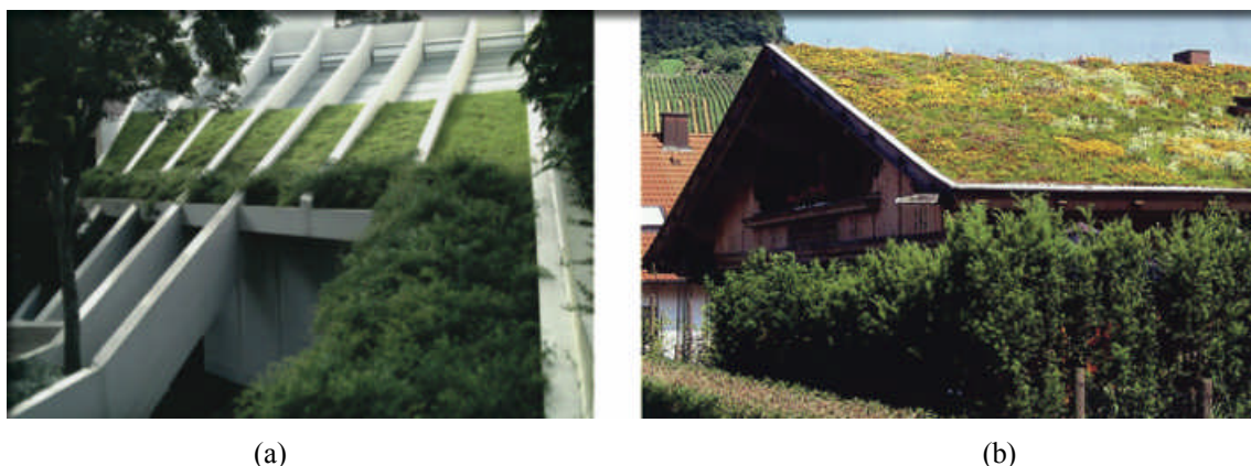
FIGURA 1 - Imagens de duas coberturas vivas extensivas: com predominância de grama (a) e predominantemente florida (b). Fonte: KREBS (2005)
