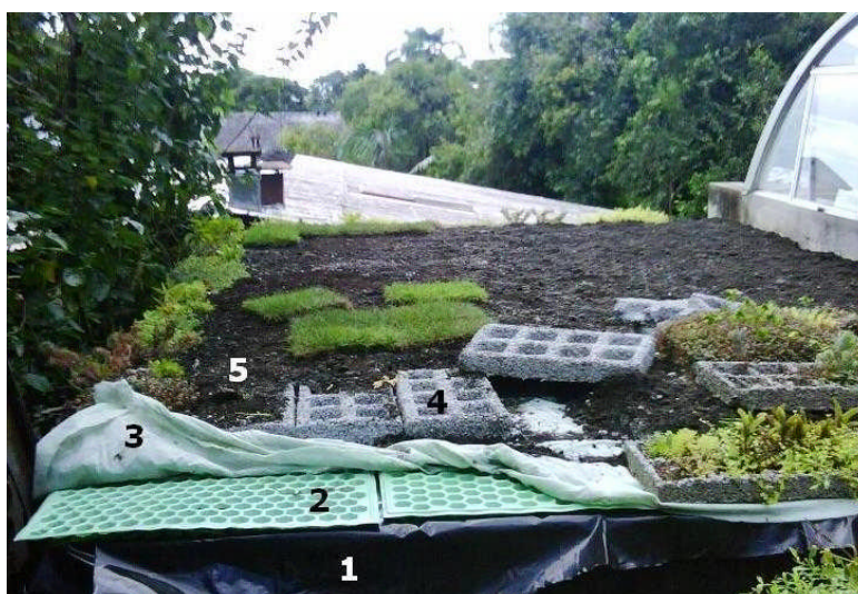
Figura 07 – Sistema Alveolar Fonte: www.ecotelhado.com.br
