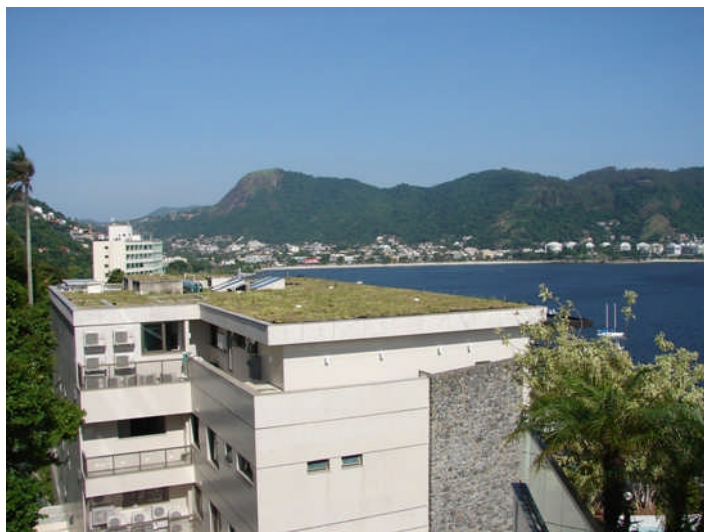
Figura 10 – Cobertura verde Sistema Alveolar - RJ Fonte: www.ecotelhado.com.br
