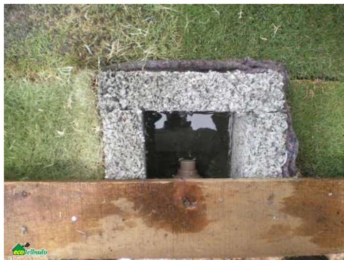
Figura 06 – Detalhe Lâmina d'água Sistema Laminar Fonte: www.ecotelhado.com.br
