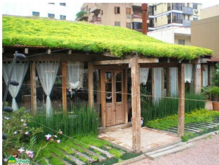
Figura 04 – Edificação comercial em Porto Alegre/RS Fonte: www.ecotelhado.com.br
