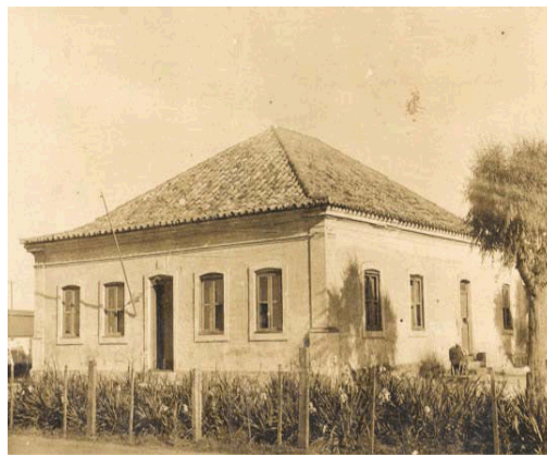
Figura 1 – Sede da Charqueada Fonte (PMP – Seurb, 1914)
