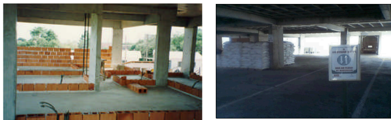
Figura 2 – Organização do canteiro: proteção
