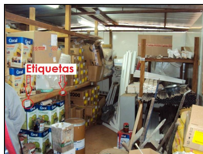
Figura 4 - Almoxarifado da obra B
