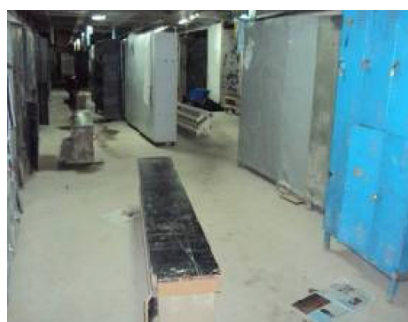
Figura 7 - Vestiário da obra C
