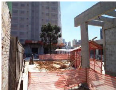
Figura 2 - Acesso coberto da obra A
