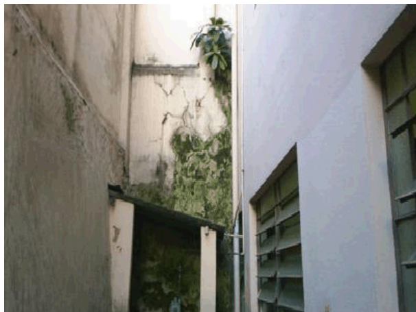
Figura 4 – Infiltração nos muros de divisa com edificações vizinhas.
