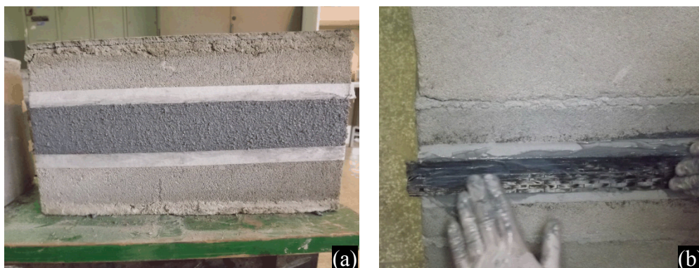
Figura 2. (a) Regularização da superfície para aplicação do reforço; (b) Posicionamento da faixa de reforço
