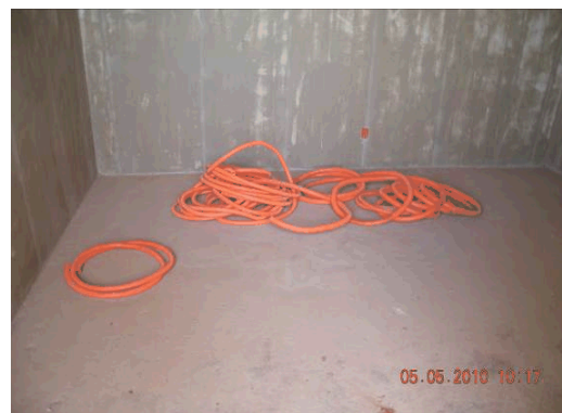
Figura 5 - Armazenamento indevido de mangueiras para instalações elétricas.
