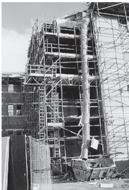
Figura 1 - Descarga de entulho com tubo coletor em caçamba basculante
