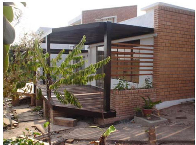
Figura 10: Foto ext. Fachada norte da Casa Bioclimática (com pergolado à norte, e vertical a oeste com parede dupla)
