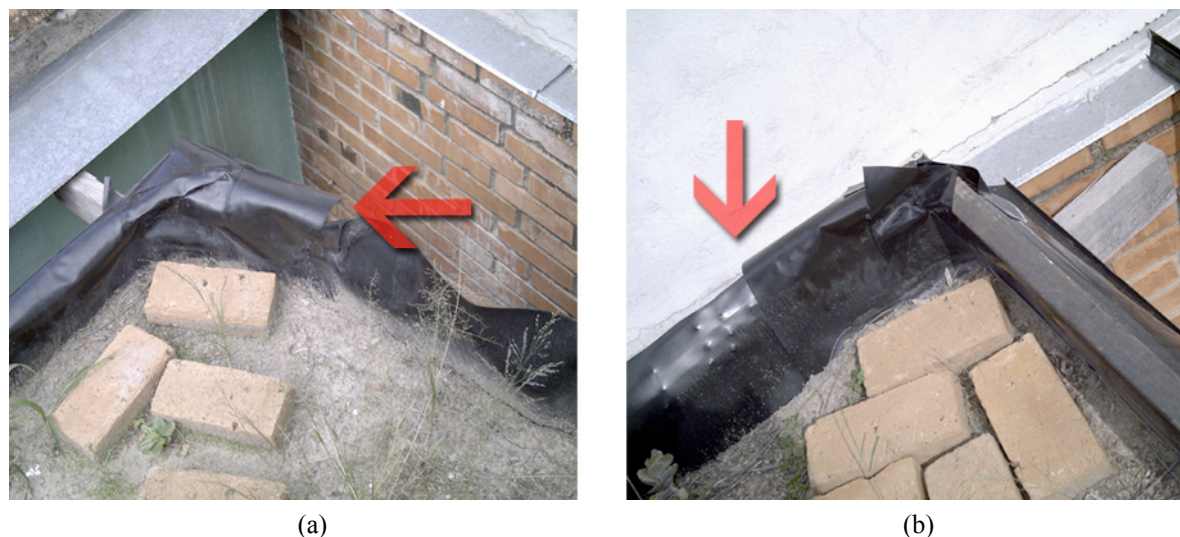
Figura 4 - recortes da manta nas bordas (a) e sobreposição da manta (b)
